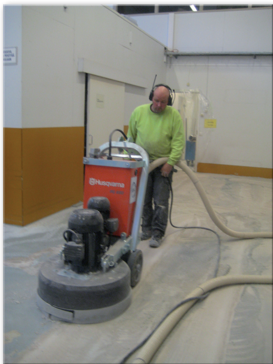
Kuvassa Harri Koljonen työstää pesulan lattian epoksipinnoitetta.
